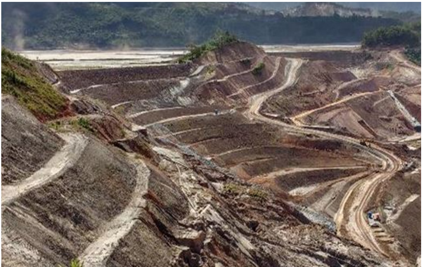
Figura 23 – Construção de berma de equilíbrio na barragem de Germano
