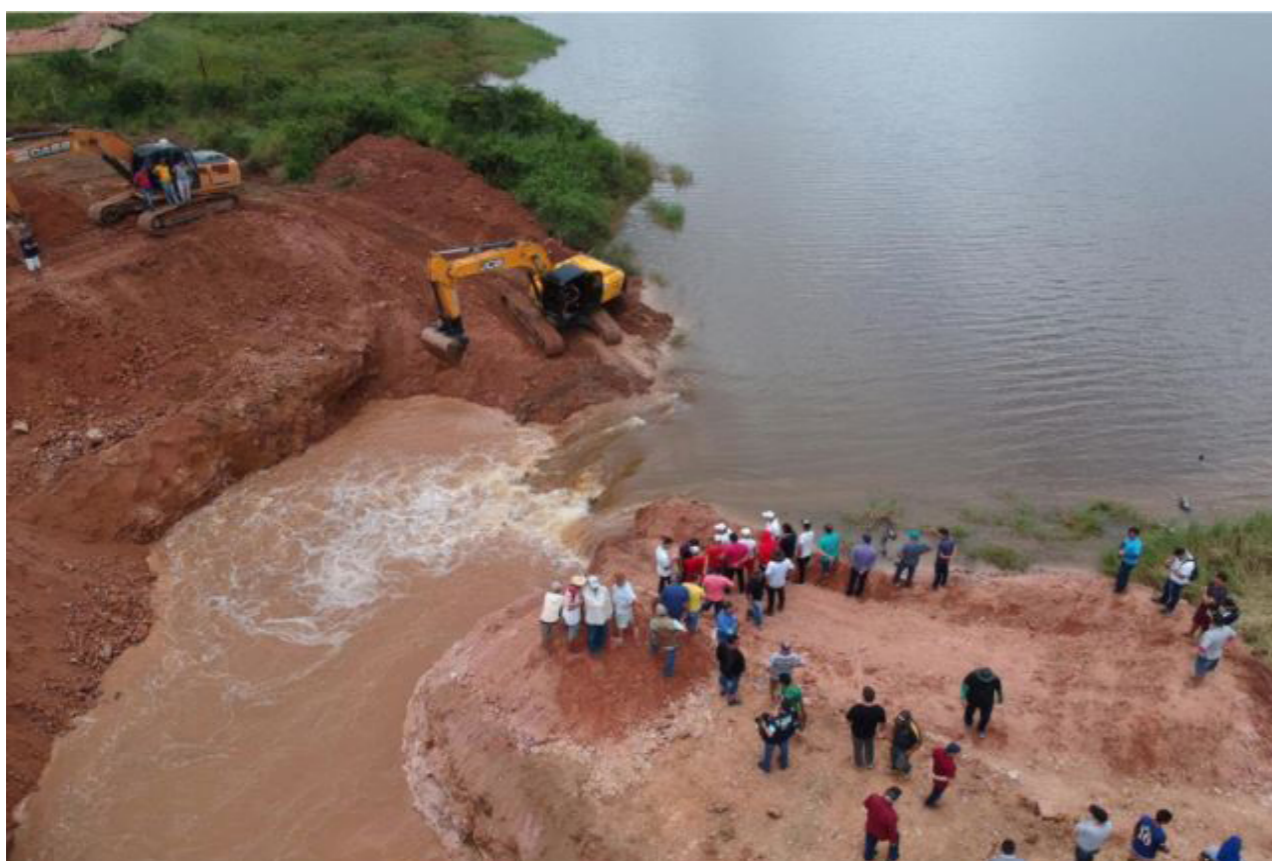
Abertura emergencial de canal extravasador na barragem de Granjeiro (2019) Foto: Prefeitura Municipal de Ubajara/CE
