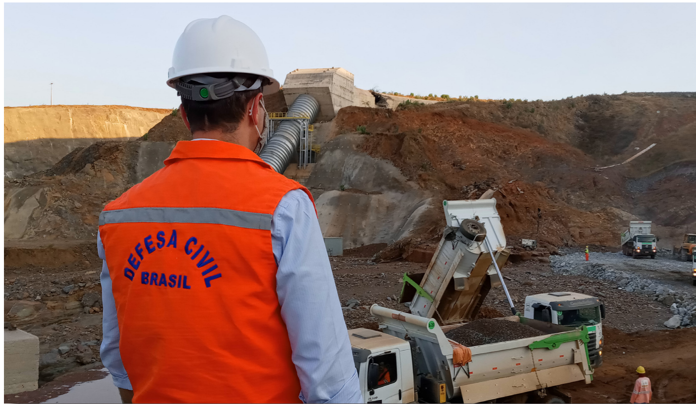
Obras emergenciais durante incidente na Barragem do Jati/CE Foto: SEDEC
