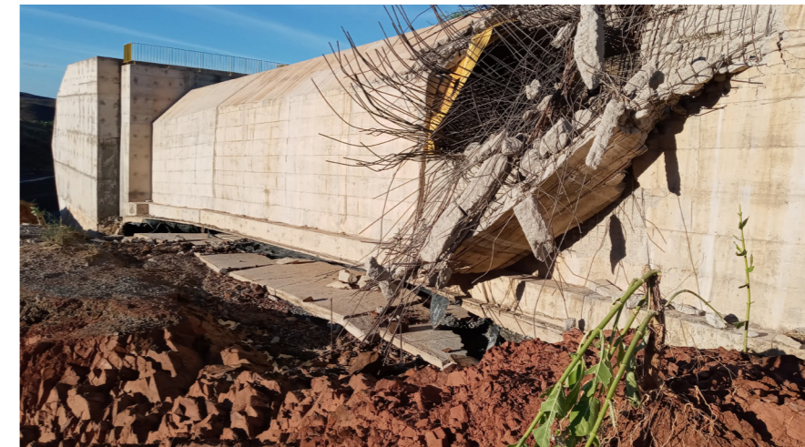
Conduto de tomada d'água rompido. Foto: SEDEC
