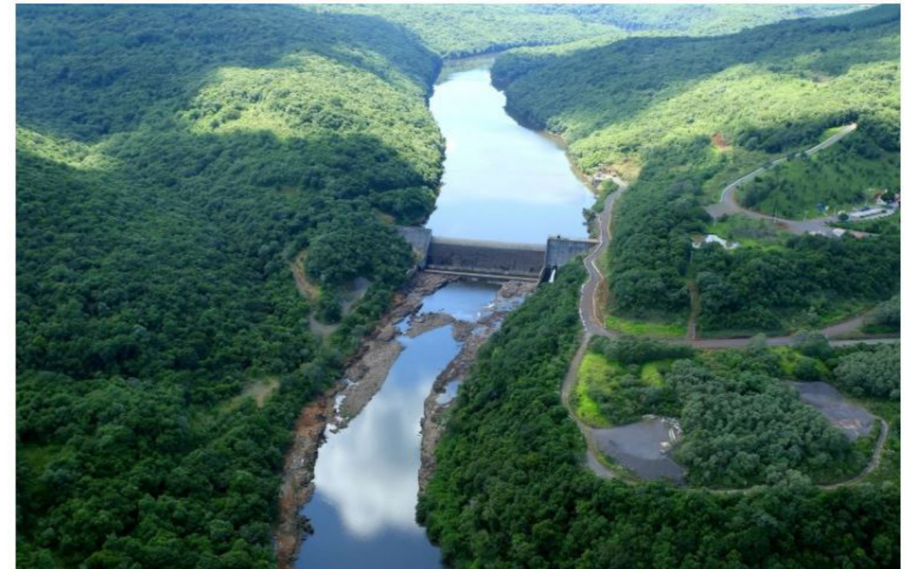
Barragem da PCH Passo do Meio Foto: Institucional APINE / Brookfield.
