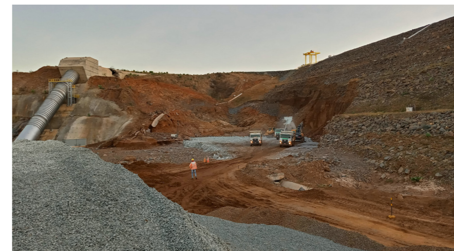
Obras emergenciais na barragem. Foto: SEDEC
