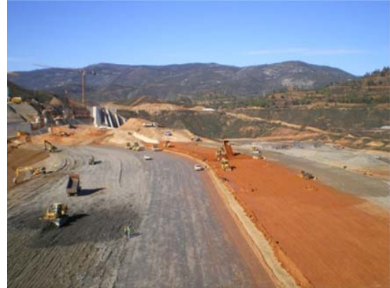
Aterro zonado - espalhamento e compactação (COBA)
