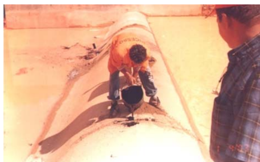
Tratamento de juntas da soleira (Creager) de Jaburu I, CE (COBA)
