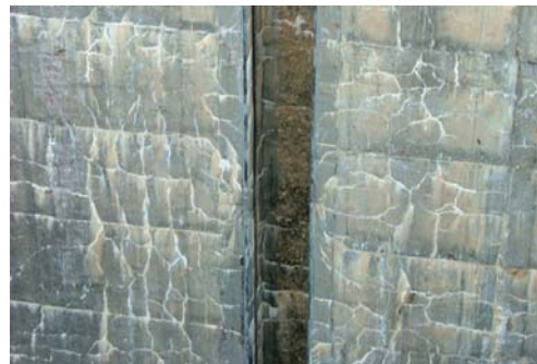
Parede Interna de eclusa, Brasil (SBB)
