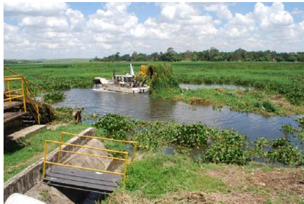
Retirada de material flutuante do reservatório (SBB)
