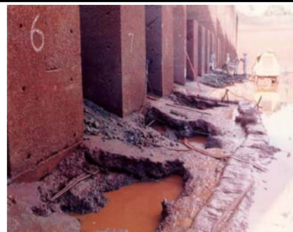
Barragem de Porto Colombia, SP/MG
