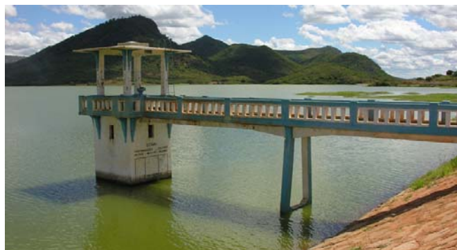
Tomada de água. Barragem de Lucrécia, (SEMARH-RN)
