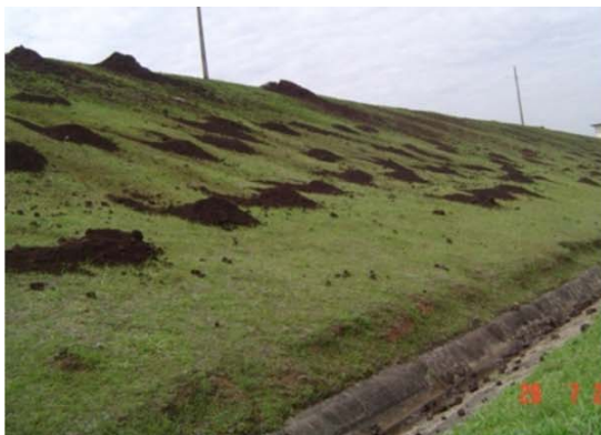
Reposição de cobertura vegetal (Barragem de Aracoiaba, CE; (COBA)
