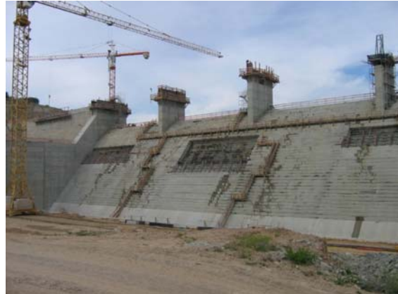
Barragem de Pedrógão, Portugal CCR (EDIA, SA)
