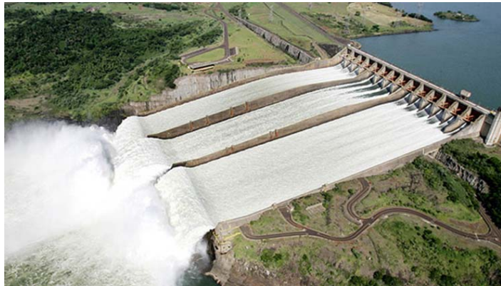
Barragem de Itaipu. Vertedouro(SBB)
