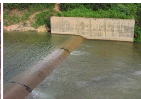
Tratamento de juntas da soleira (Creager) de Jaburu I, CE (COBA)
