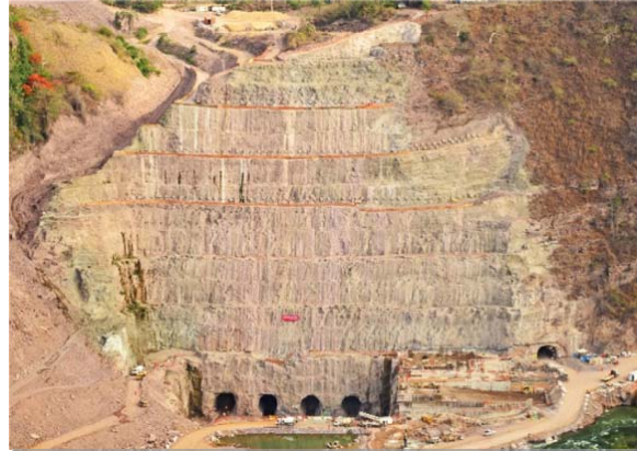
Escavação a céu aberto (Cambambe, Angola) (COBA, SA)
