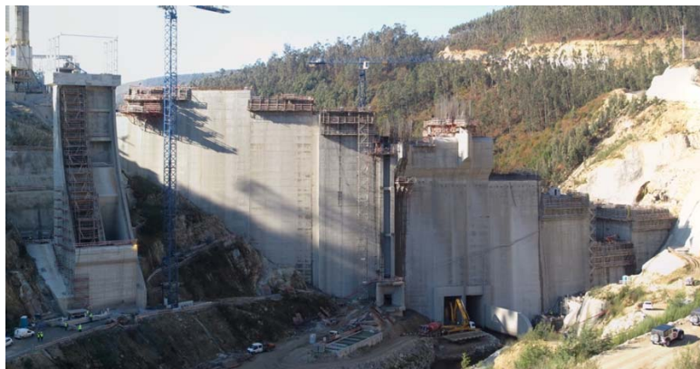
Barragem de Ribeiradio, Portugal (concreto convencional)(COBA, SA)
