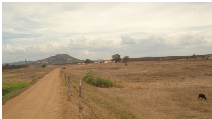
Figura III. 6 – Zona de vegetação verdejante no talude de jusante da barragem
