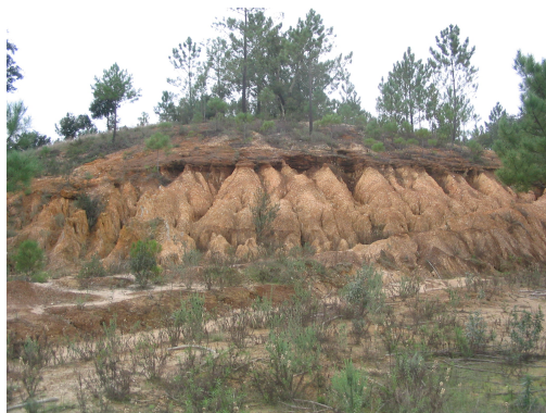
Figura III. 19 – Forte ravinamento dos taludes do reservatório
