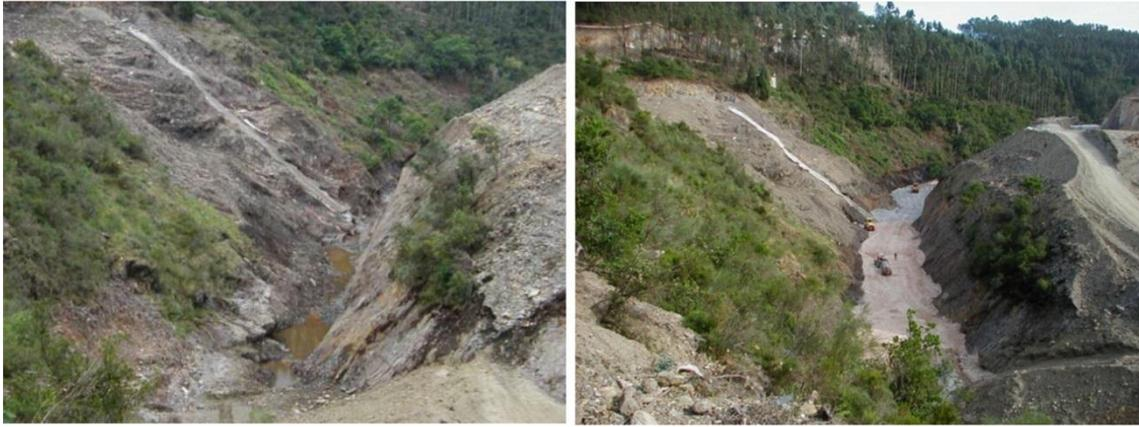
**Figura 9. Geometria do vale desfavorável (muito encaixado) para uma barragem de aterro, potencializando a ocorrência de efeito de arco. (Fonte: COBA, S.A.)**
