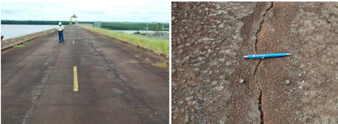
**Figura 10. Fissuras longitudinais na crista de uma barragem de terra no Brasil, instrumentada com pares de pinos. (Fonte: SBB Engenharia)**
