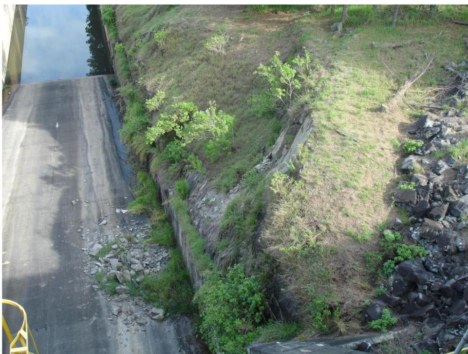
**Figura 41. Queda de blocos de rocha do talude lateral sobre a calha do Vertedouro da barragem de Jaguari da SABESP, SP. (Fonte: SBB Engenharia)**
