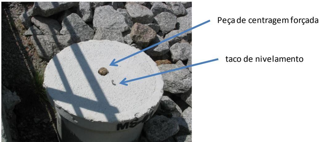
**Figura 53. Marco topográfico para monitorização de deslocamentos verticais e horizontais. (Fonte: COBA, S.A.)**
