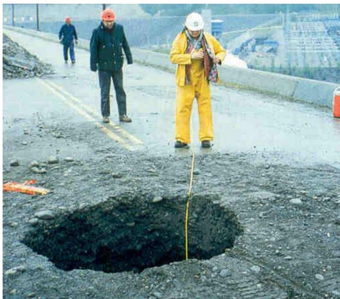
**Figura 15. Afundamento (*Sinkhole*) na crista da barragem de Bennett, Canadá. (Water Power & Dam Construction, Fev 1997).**
