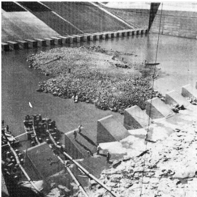
**Figura 40. Erosão por abrasão, pela ação de blocos de rocha, no Vertedouro da barragem de Marimbondo, SP/MG. (Fonte: CBDB – XV SNGB, 1983)**
