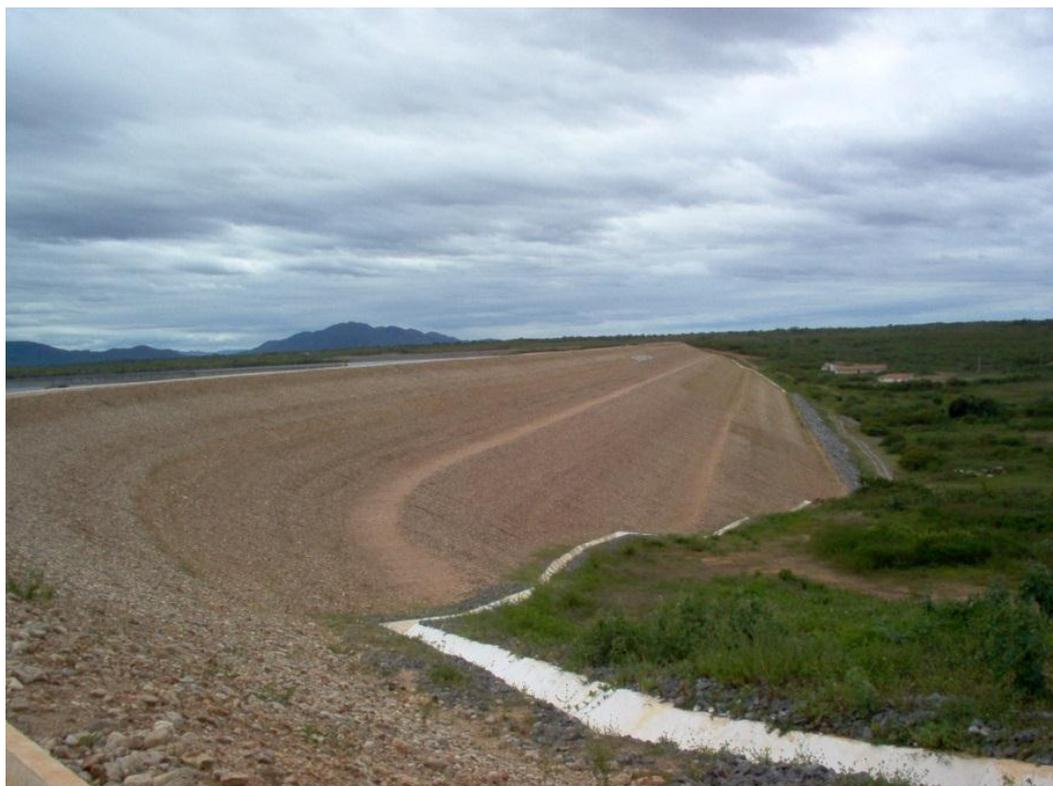
**Figura 26. Talude de jusante revestido com cascalho (Barragem de Aracoiaba, CE.**
