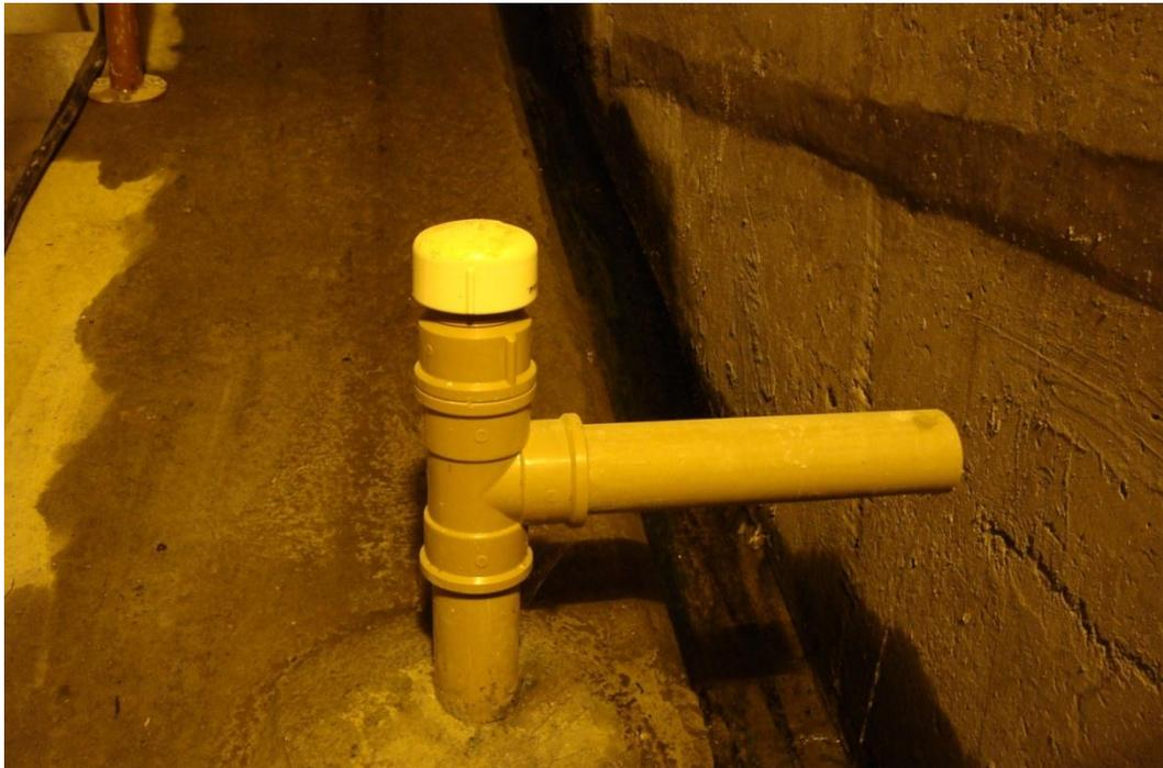
**Figura 69. Terminal de dreno de fundação em “T” para facilitar as operações periódicas de limpeza. (Fonte: SBB Engenharia)**
