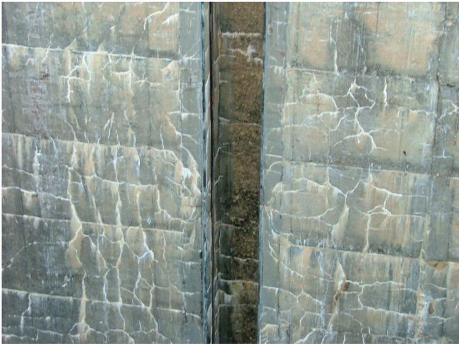
**Figura 33. Fissura tipo “mapa” provocadas pela RAA- Reatividade Álcali-Agregado na parede interna de uma eclusa, no Brasil. (Fonte: SBB Engenharia)**
