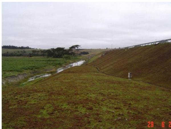
**Figura 25. Ação de manutenção com reposição de cobertura vegetal. (Fonte: COBA, S.A.)**
