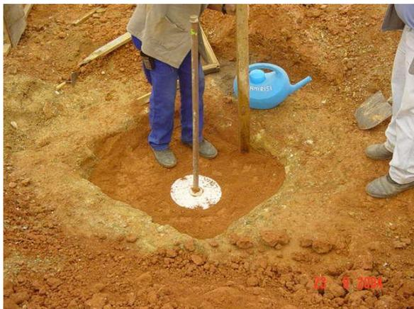
As placas, introduzidas num tubo-guia, dentro do qual se desloca o pio magnético para leitura das cotas das placas ao longo do tempo, vão sendo colocadas às cotas pré-definidas sobre a superfície do aterro, quando atingirem essas mesmas cotas.
