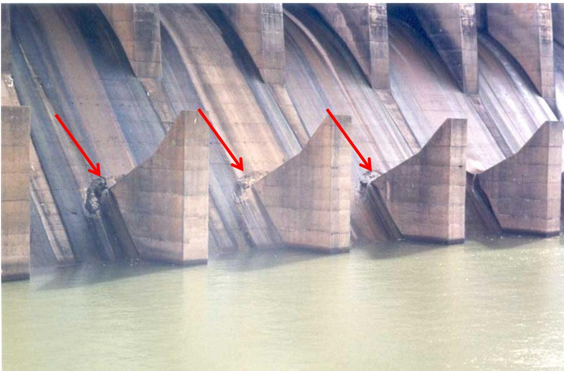
**Figura 39. Erosão por cavitação junto aos blocos defletores na calha do Vertedouro de Ilha Solteira, SP/MS. (Fonte: SBB Engenharia)**
