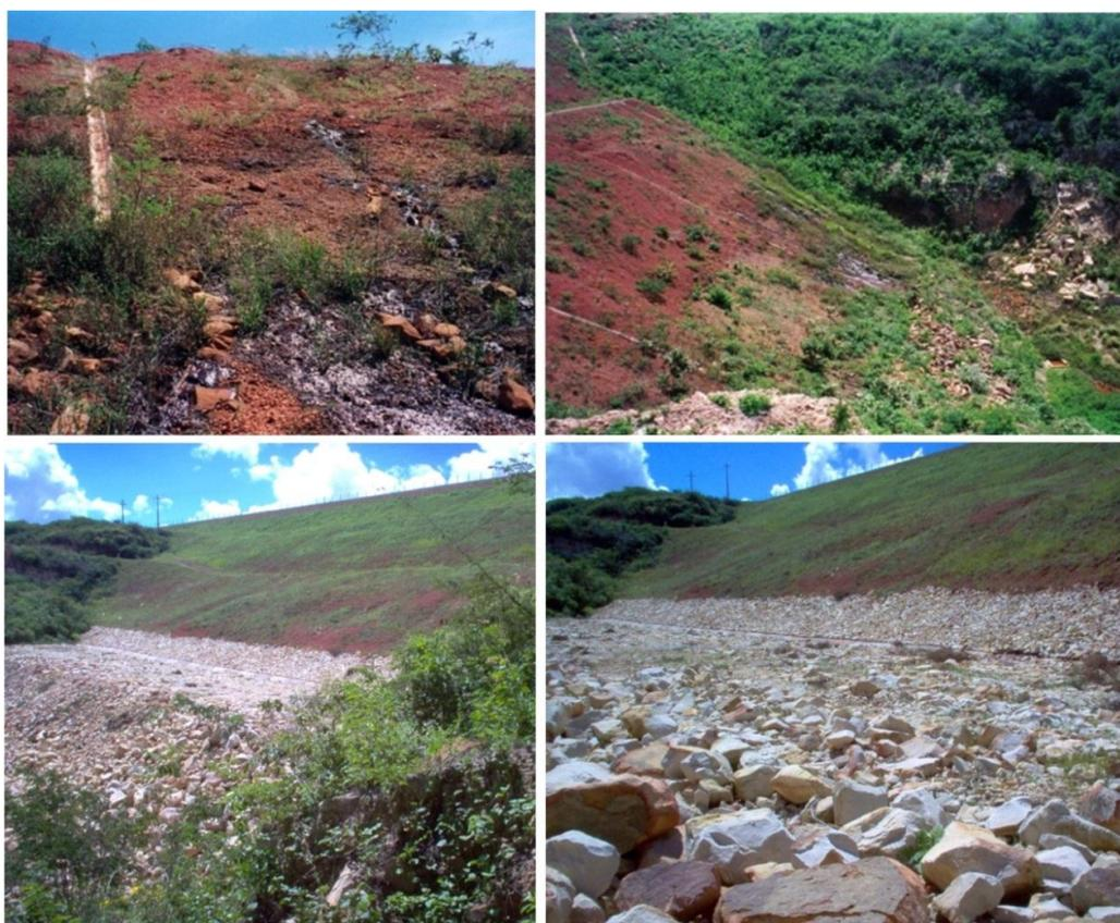
**Figura 7. Surgências de água no talude de jusante e reabilitação (fotos inferiores) com maciço estabilizador do pé de jusante e tapete drenante sobre esporões afastados 10 m uns dos outros na Barragem de Jaburu I, CE. (Fonte: COBA, S.A.)**
