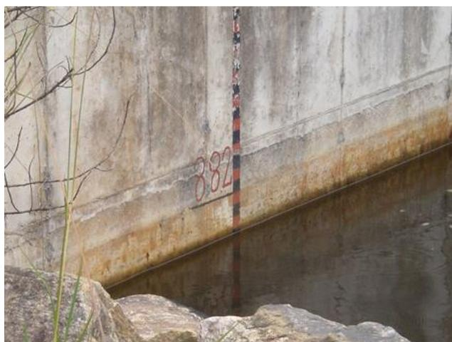
**Figura 51. Réguas limnimétricas. Figura 52. Escala limnimétrica no muro do vertedouro.** (Fonte: COBA, S.A.)
