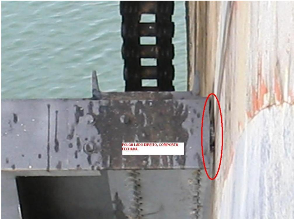
**Figura 29. Roçamento da comporta com o pilar do vertedouro da barragem de concreto de Pedra, BA afetada por RAA. (Fonte: SBB Engenharia)**
