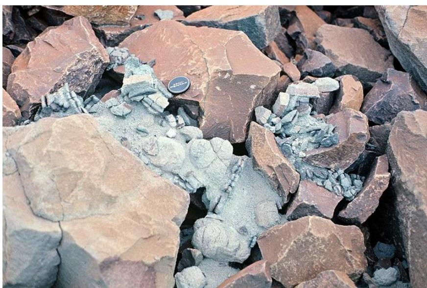
**Figura 3. Desagregação de blocos de basalto no rip-rap de uma barragem de terra no Brasil.** (Fonte: SBB Engenharia)
