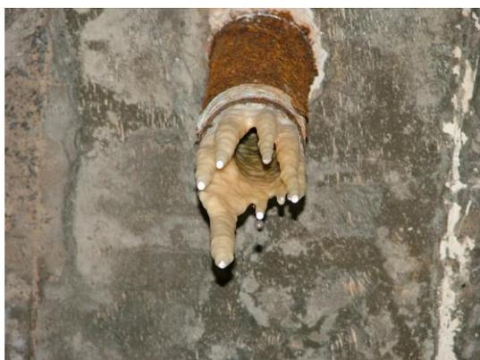
**Figura 27. Dreno parcialmente obstruído por crosta de carbonato.**
