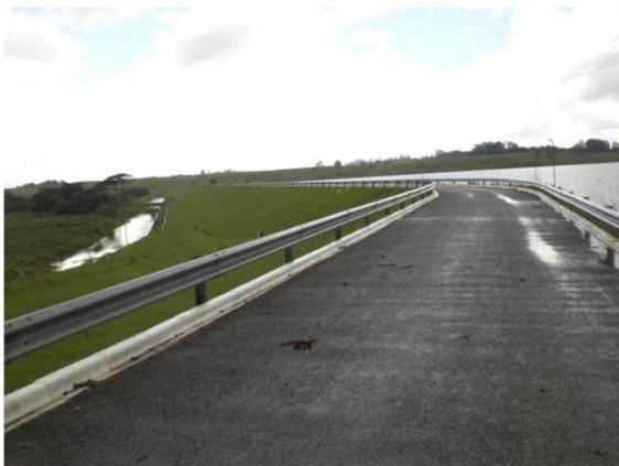
**Figura 18. Água acumulada no pavimento, resultante de deficiente drenagem.**
