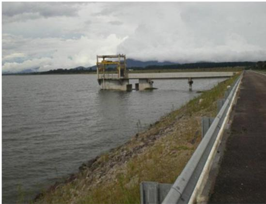
**Figura 46. Vertedouro em poço, em funcionamento. (Fonte: COBA, S.A.)**
