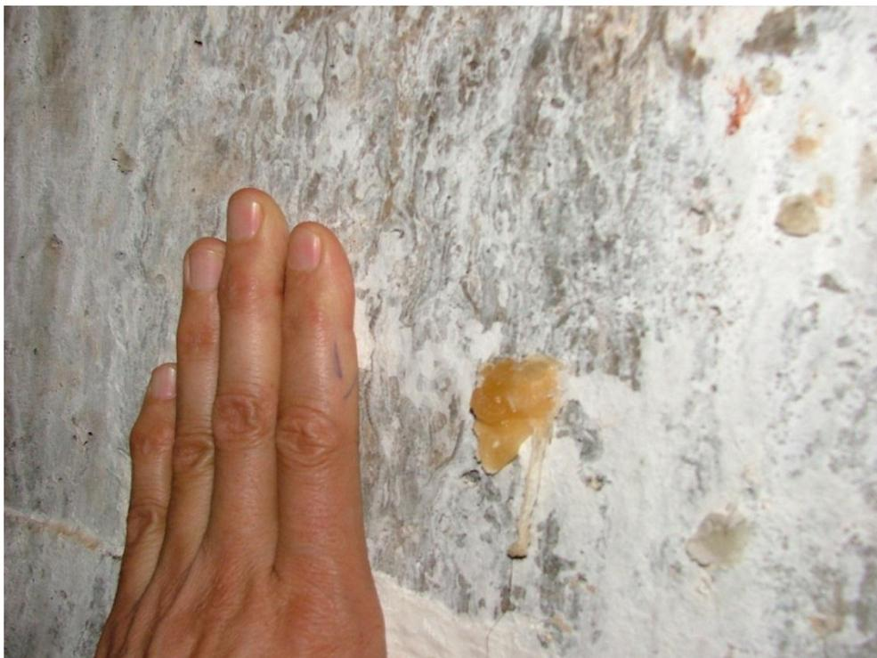
**Figura 34. Exsudação de gel álcali-silica na parede de drenagem de uma barragem afetada pela RAA. (Fonte: SBB Engenharia)**
