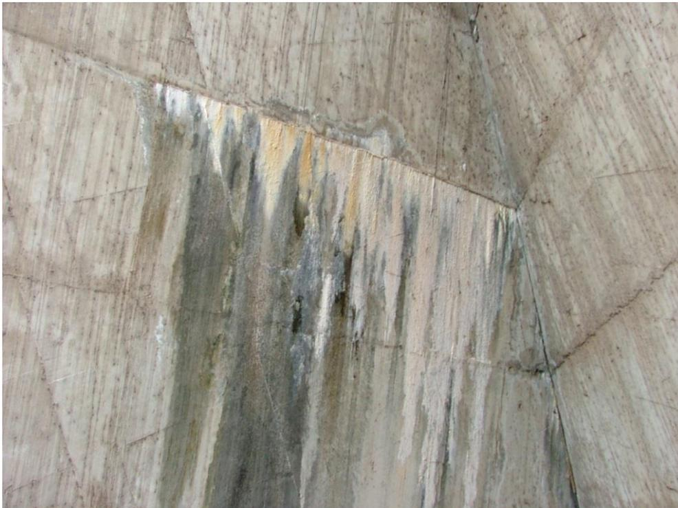
**Figura 30. Infiltração com carbonatação através de uma junta entre camadas de concretagem no paramento de jusante de uma barragem gravidade-aliviada. (Fonte: SBB Engenharia)**
