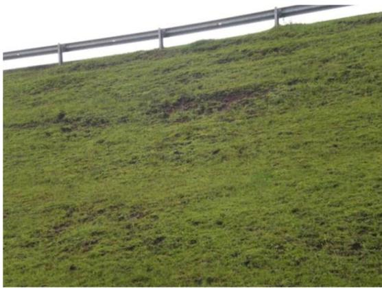
**Figura 21. Talude de jusante da barragem com deslizamentos superficiais. (Fonte: COBA, S.A.)**
