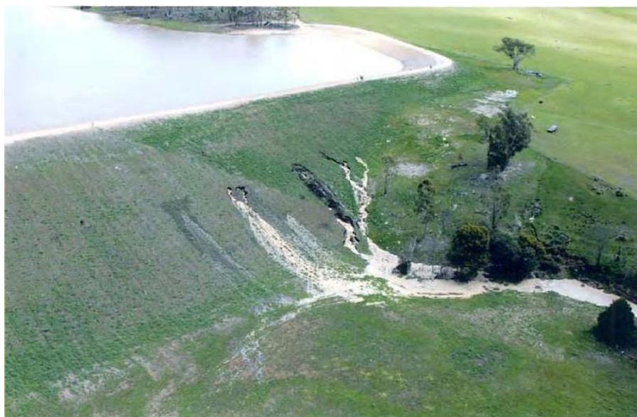
**Figura 2. Barragem de terra em processo de *piping* através do aterro.**
