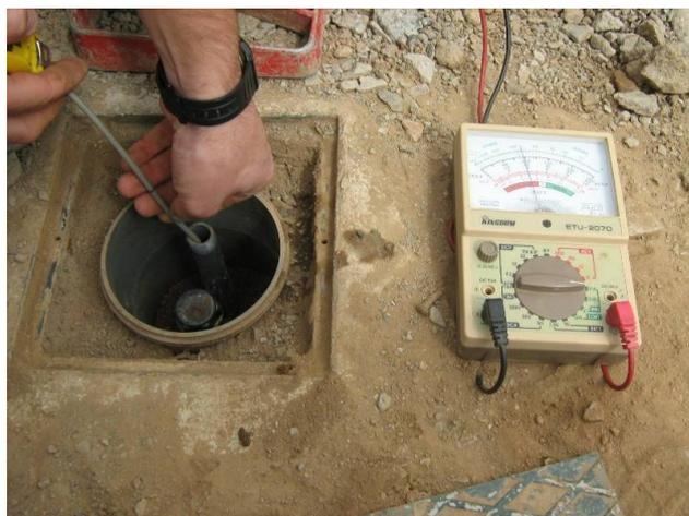
**Figura 59. Medição do nível piezométrico.**
