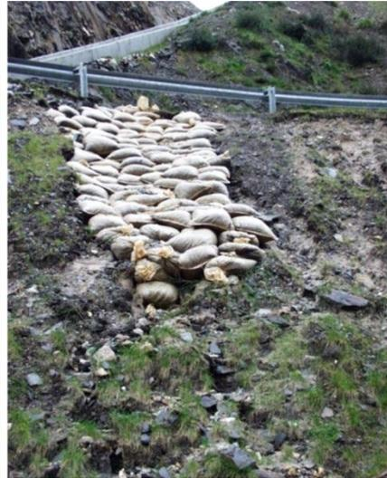
**Figura 14. Deslizamentos do talude de jusante e reparação de emergência com sacos de areia. (Fonte: COBA, S.A.)**
