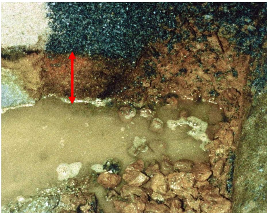
**Figura 5. Colmatção das camadas de areia, pedrisco e brita na zona de oscilação do NA (seta) junto ao dreno de pé de uma barragem de terra pela ação de ferro-bactérias. (Fonte: SBB Engenharia)**
