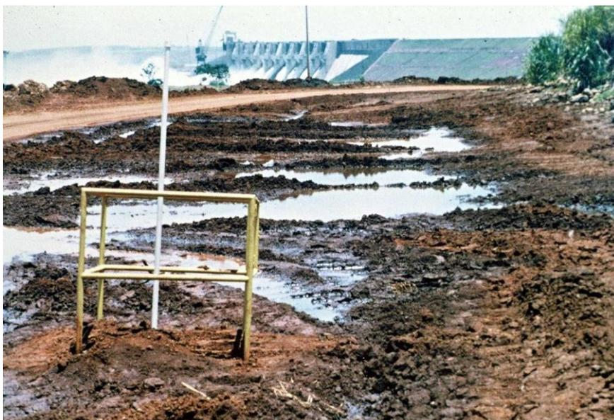
**Figura 6. Surgência a jusante da Barragem de Água Vermelha, SP/MG, devido a uma camada de brecha basáltica muito permeável na fundação, logo após o enchimento do reservatório, em 1978. (Fonte: SBB Engenharia)**
