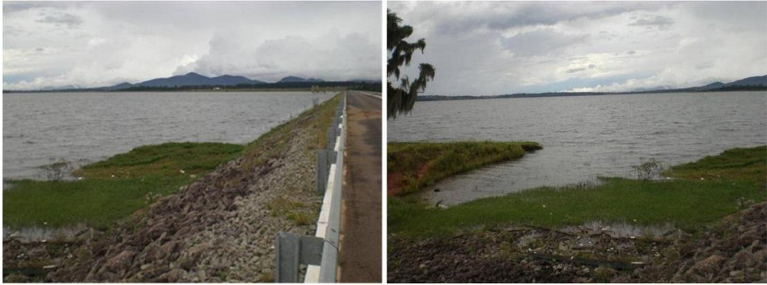
**Figura 45. Acumulação de vegetação sobrenadante no reservatório, junto ao talude de montante da barragem. (Fonte: COBA, S.A.)**
