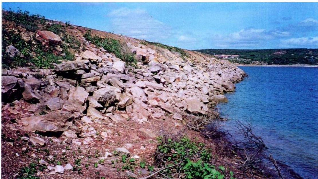
**Figura 17. Talude de montante, com região superior sem proteção, e rip-rap mal colocado e deslocado, Jaburu I, CE. (Fonte: COBA, S.A.)**
