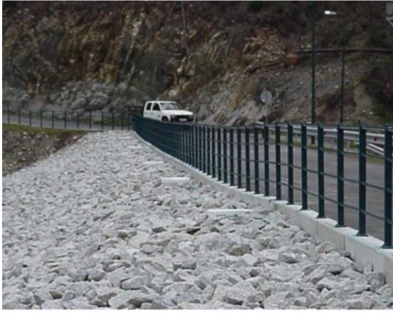
**Figura 12. Deformação excessiva na crista da barragem iniciando deslizamento do talude. (Fonte: COBA, S.A.)**
