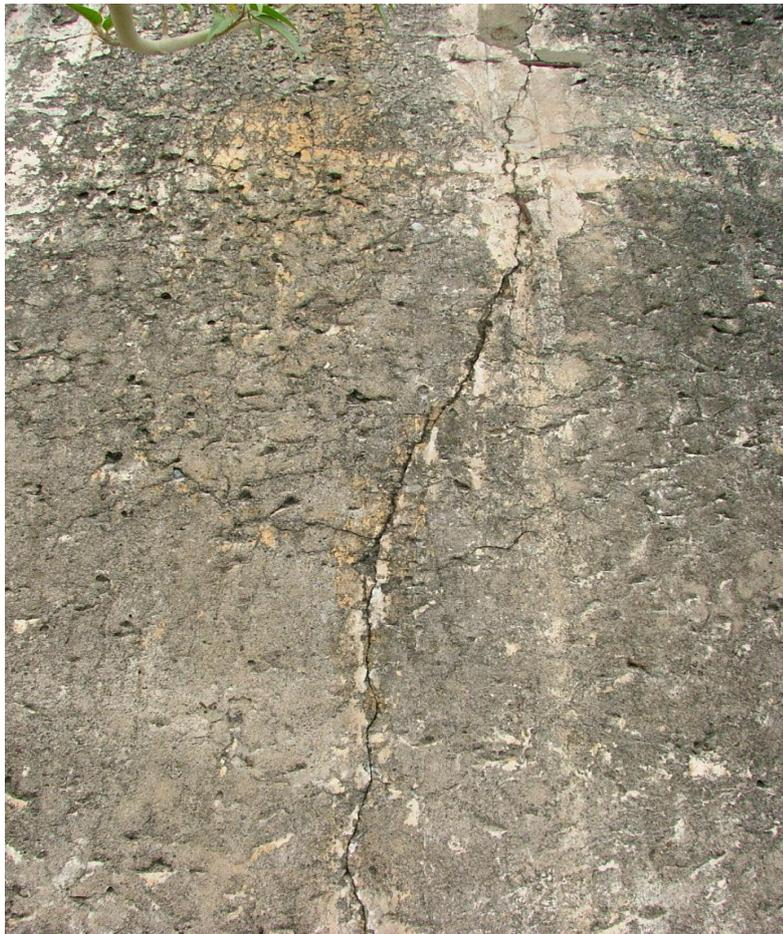
**Figura 31. Fissura subvertical de origem térmica ( $e = 2,0 \text{ mm}$ ), no paramento de jusante de uma barragem tipo gravidade. (Fonte: SBB Engenharia)**
