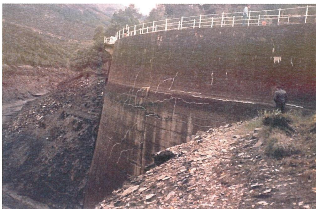
**Figura 36. Fissuração numa barragem afetada por um processo expansivo do concreto (Barragem do Alto Ceira, Portugal). (Fonte: PEDRO, 2001)**
