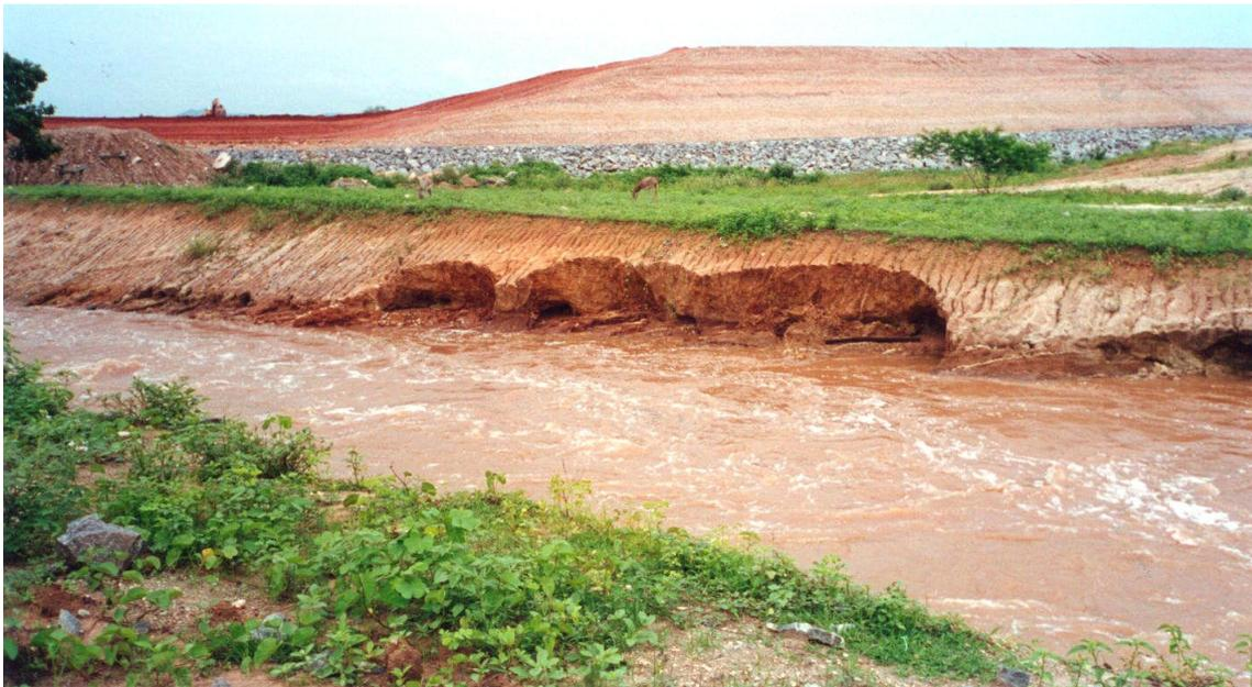
**Figura 37. Erosão do talude do canal extravasor da descarga de fundo/tomada de água (Barragem de Aracoiaba, CE. (Fonte: COBA, S.A.)**
