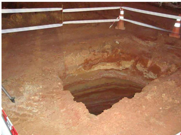
**Figura 16. Afundamento devido a erosão interna, observado no aterro durante os trabalhos de reabilitação da barragem do Gove, Angola. (Fonte: COBA, S.A.)**
