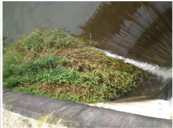
**Figura 47. Vegetação a ser arrastada para o interior do poço do vertedouro. (Fonte: COBA, S.A.)**
