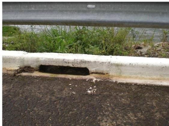
**Figura 19. Saída da água obstruída, necessitando manutenção.**
