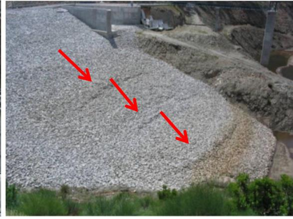
**Figura 13. Deslizamentos no talude de montante. (Fonte: COBA, S.A.)**
