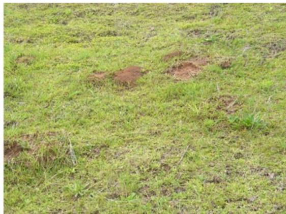
**Figura 22. Formigueiros no talude de jusante. (Fonte: COBA, S.A.)**
