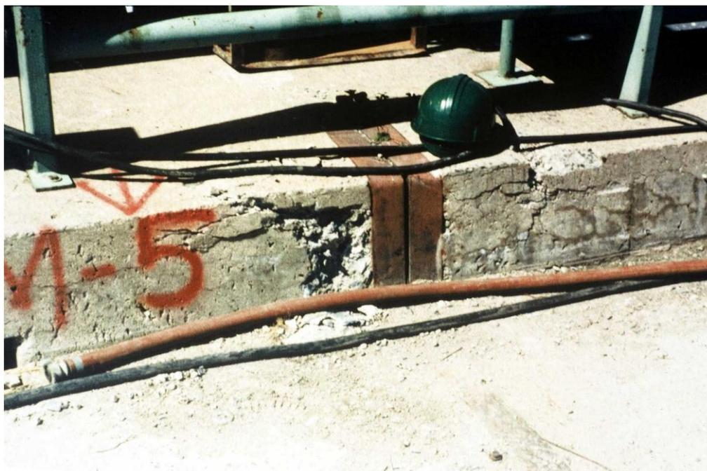
**Figura 35. Ruptura do concreto por altas tensões de compressão, na crista do Vertedouro da barragem de Mactaquac, no Canadá, afetada pela RAA. (Fonte: SBB Engenharia)**
