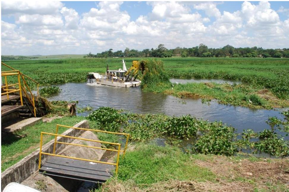
**Figura 48. Retirada de material flutuante do reservatório. (Fonte: SBB Engenharia)**
