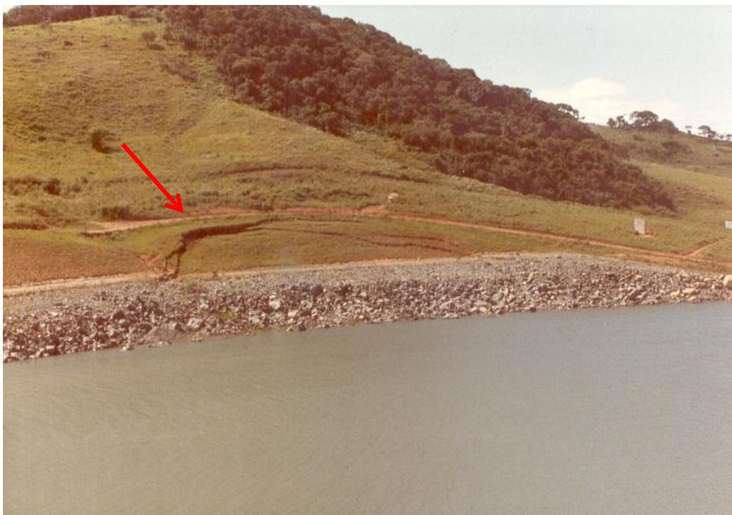
**Figura 44. Ruptura do talude lateral do canal de ligação entre reservatórios do Jacarei e Jaguari SP, da SABESP. (Fonte: SBB Engenharia)**
