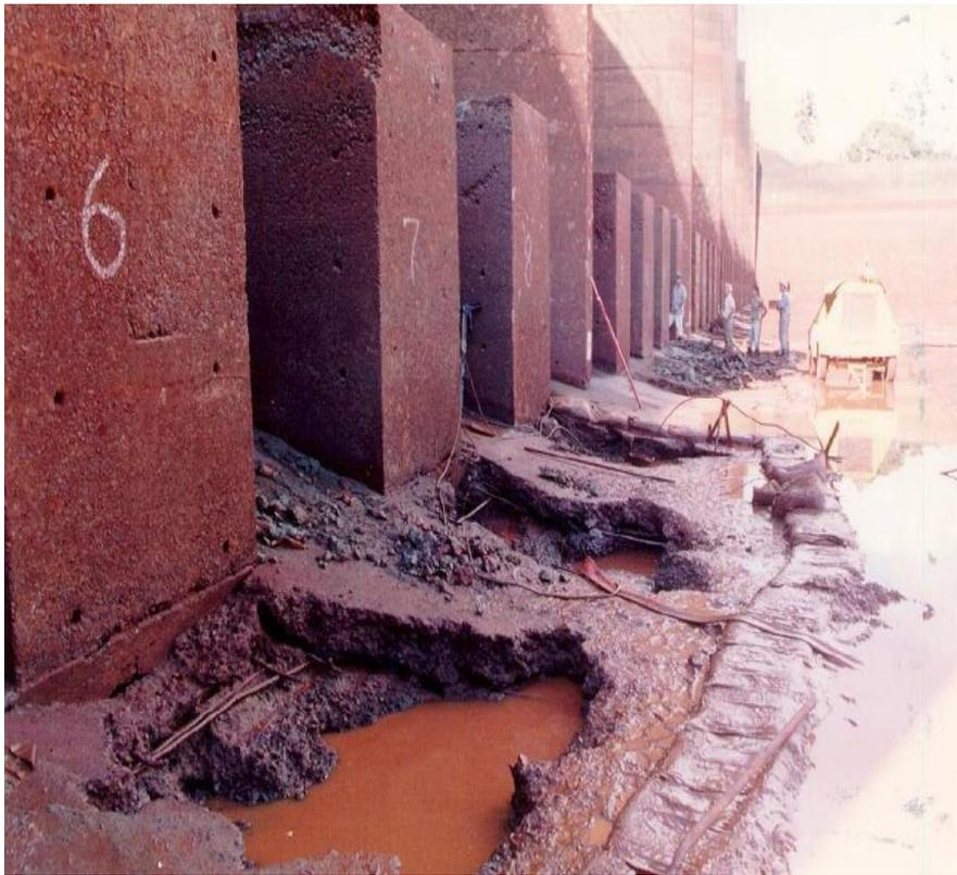
**Figura 38. Erosão por cavitação a jusante dos blocos de dissipação no Vertedouro da barragem de Porto Colômbia SP/MG. (Fonte: CBDB)**
