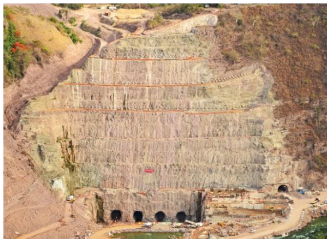
Figura 4. Escavação a céu aberto da saída do segundo circuito hidráulico de Cambambe, Angola. (Fonte: COBA, S.A.)
