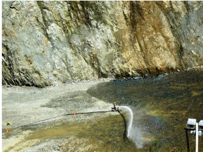
Figura 20. Irrigação do aterro de enrocamento. (Fonte: COBA, S.A.)
