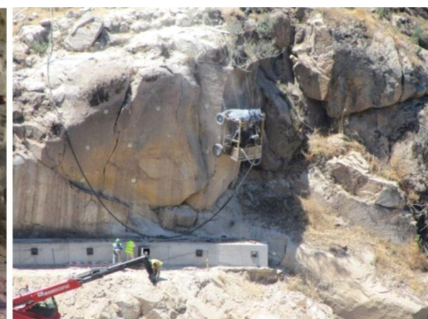
Figura 9. Viga de ancoragem ativa. (Fonte: COBA, S.A.)
