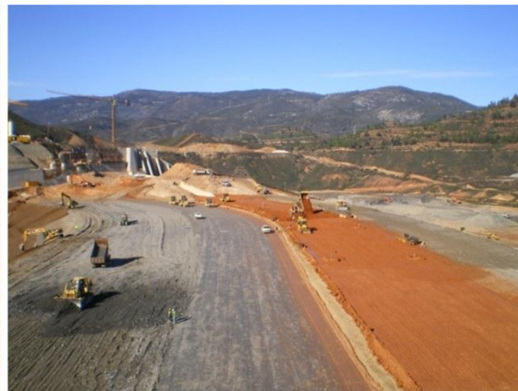
Figura 19. Aterro zonado. Operações de espalhamento e de compactação. (Fonte: COBA, S.A.)
