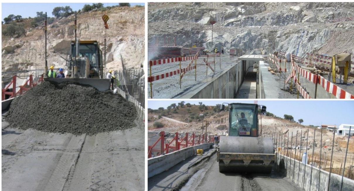
Figura 30. Aspectos da construção de blocos em CCR. (Fonte: EDIA, S.A.)
