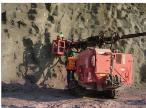
Figura 8. Aplicação de chumbadores após concretagem. (Fonte: COBA, S.A.)
