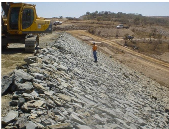
Figura 13. Proteção do talude de montante em enrocamento. (Fonte: COBA, S.A.)
