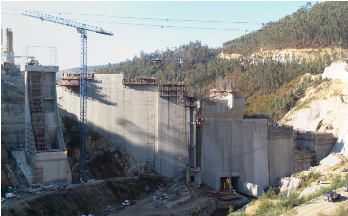
Figura 25. Barragem de concreto convencional (Barragem de Ribeiradio, Portugal). (Fonte: COBA, S.A.).
