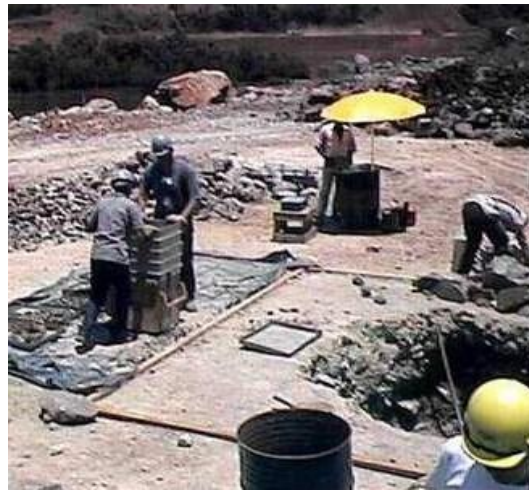
Figura 24. Ensaio granulométrico in situ de enrocamento. (Fonte: WATZKO, 2007)
