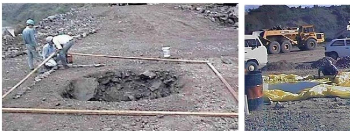
Figura 23. Ensaio de densidade in situ de enrocamento. (Fonte: WATZKO, 2007)
