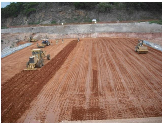
Figura 18. Aterro homogêneo. Operações de escarificação e de compactação. (Fonte: COBA, S.A.)
