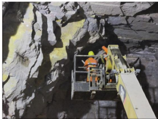
Figura 12. Escavações subterrâneas. Remoção de blocos soltos. (Fonte: COBA, S.A.)
