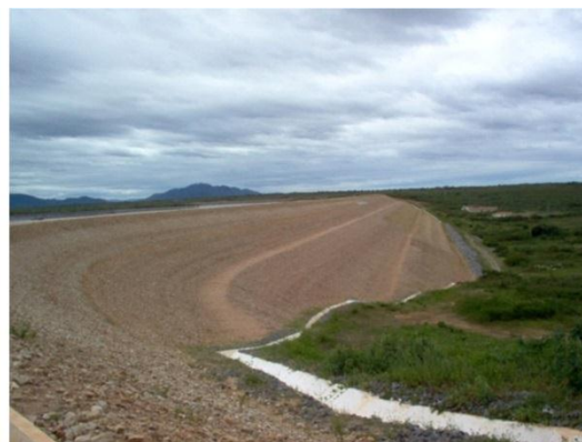
Figura 15. Proteção do talude de jusante em cascalho. (Fonte: COBA, S.A.)
