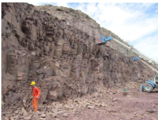
Figura 6. Remoção de blocos soltos. (Fonte: COBA, S.A.)
