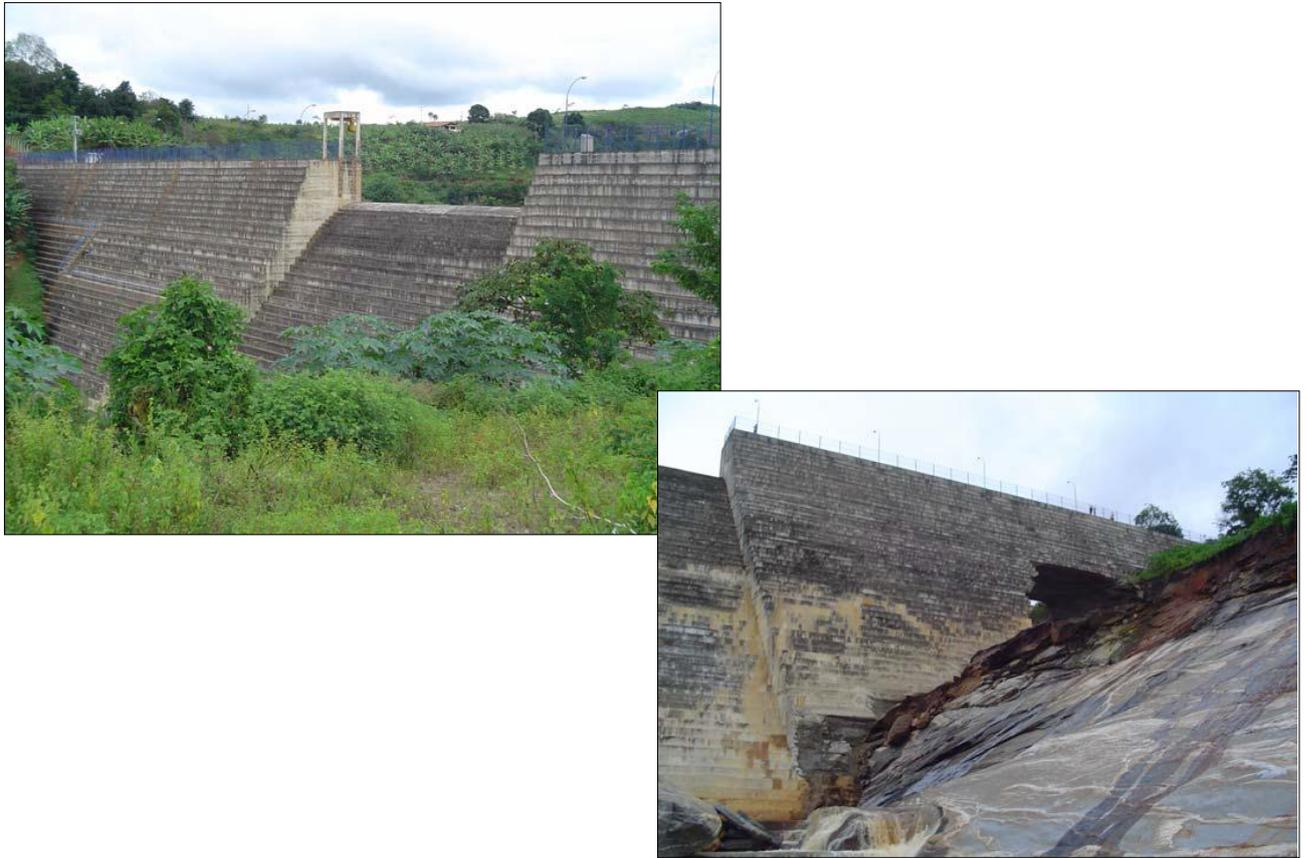
Figura 2 – Barragem Algodões (Piauí) depois da falha e ruptura
