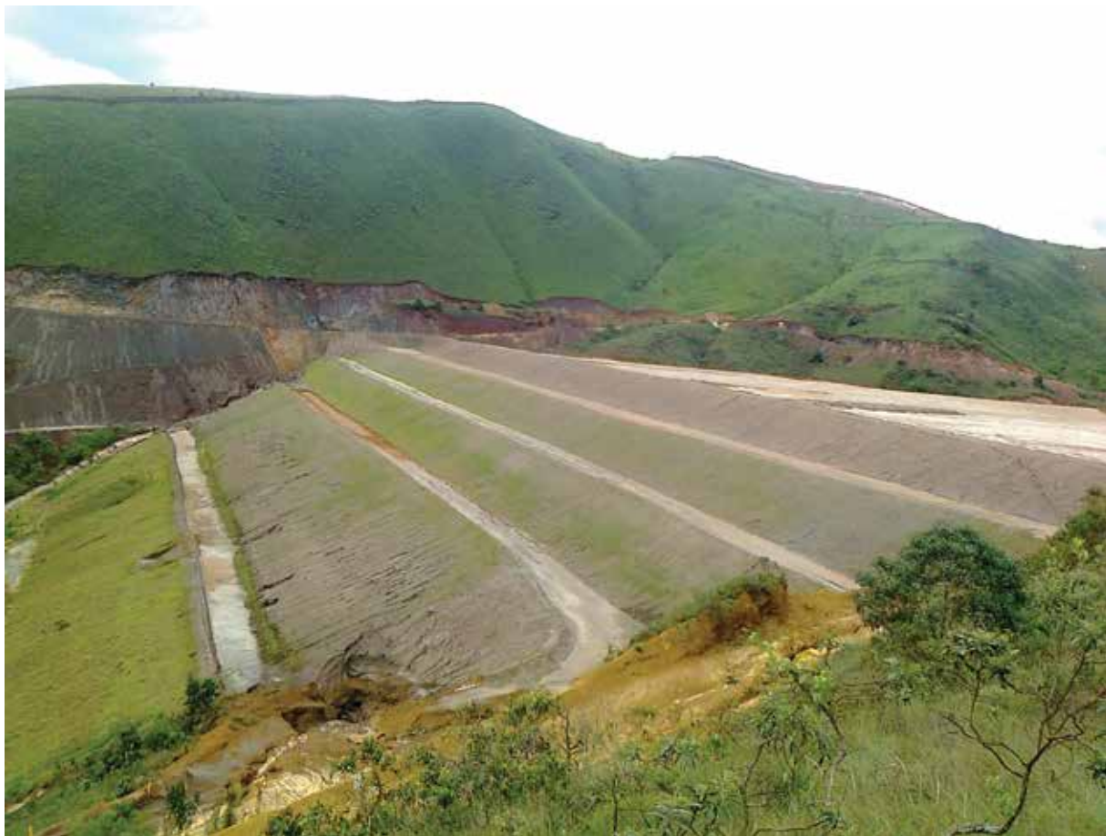
Figura 3. Barragem de rejeito de mineração da empresa Gerdau.
