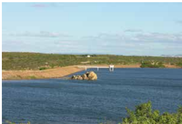
Figura 1. Açude de Mendubim.
