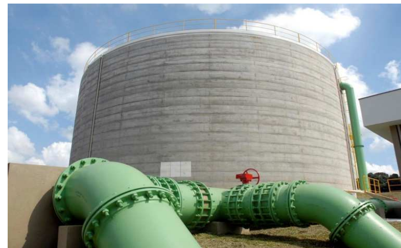
Reservatório Campo do Santana
