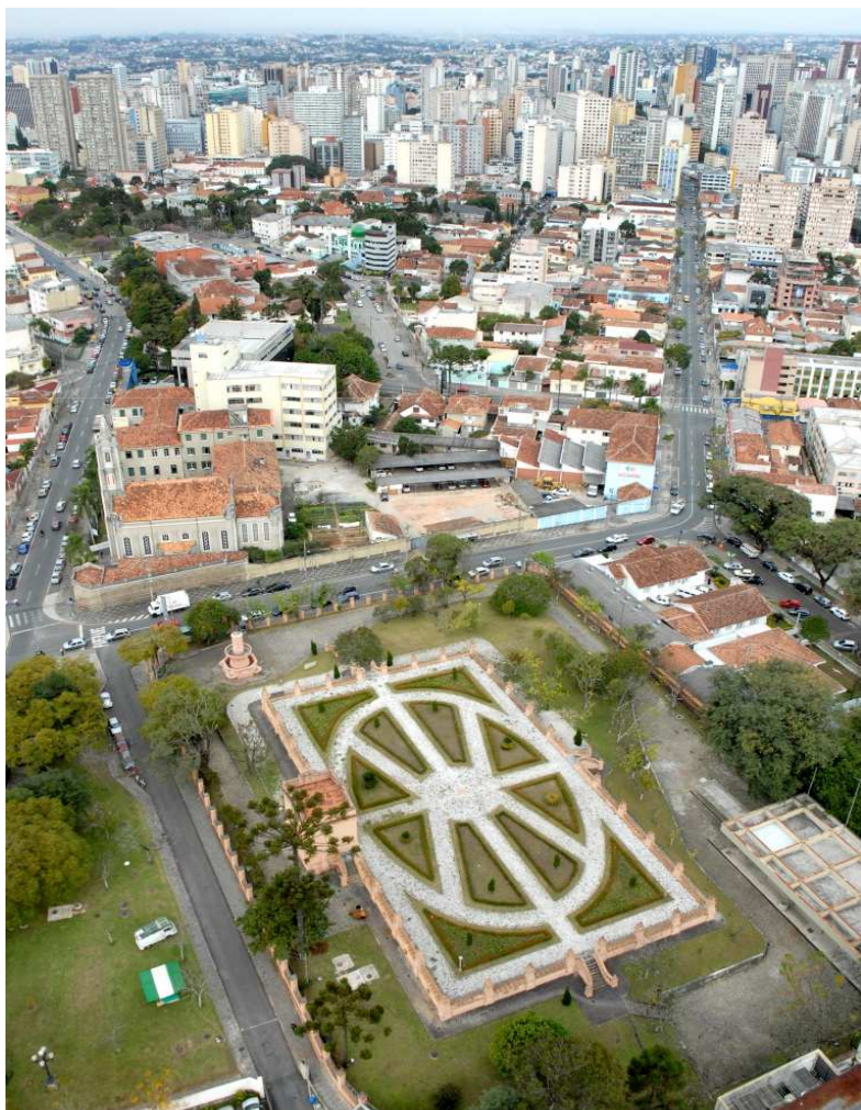
Reservatório São Francisco
