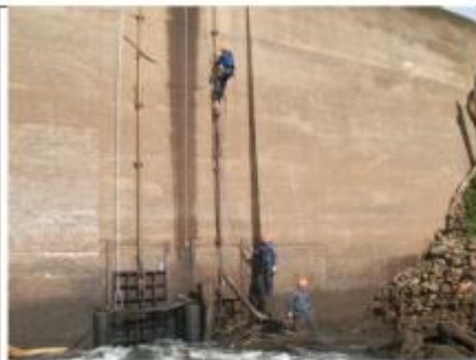
Talude de montante da barragem Laranjeiras (Fonte: Defesa Civil-Três Coroas)
