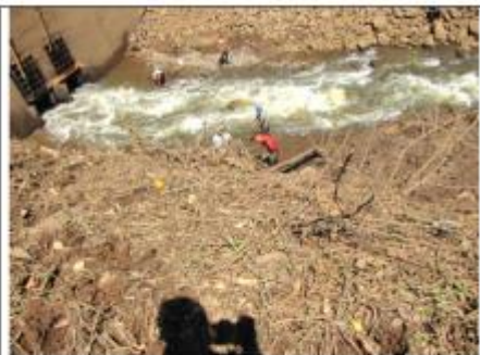
Leito do rio Paranhana a montante da barragem Laranjeiras (Fonte: Defesa Civil-Três Coroas)
