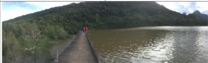
Vista superior da barragem Laranjeira com talude (centro) e reservatório (direita)
