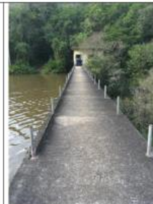
Vista superior da barragem Laranjeira com talude (centro) e reservatório (esquerda)
