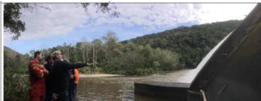
Vista do pé da barragem e vertedor
