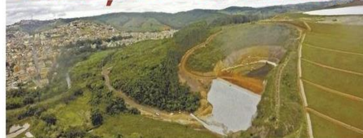
Imagem aérea mostra proximidade entre a estrutura de contenção de resíduos minerários e bairros de Congonhas. Plano emergencial mobiliza autoridades para agir em caso de problemas e evitar catástrofe
