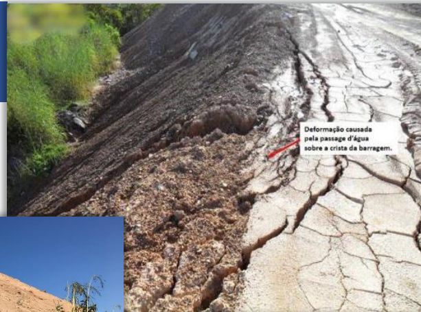
Vista da crista da barragem, mostrando invasão de água sobre a pista.
