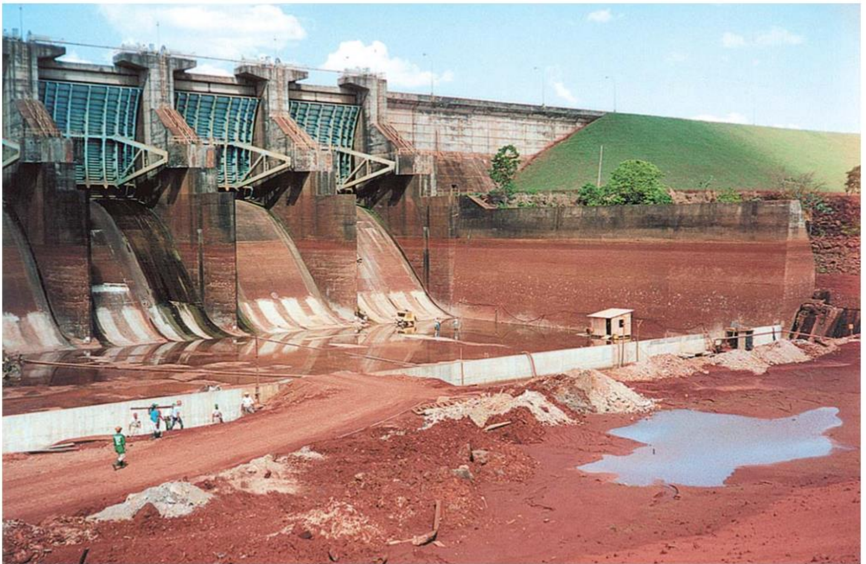
Foto 7 - Vista do vertedouro na conclusão das obras de recuperação
