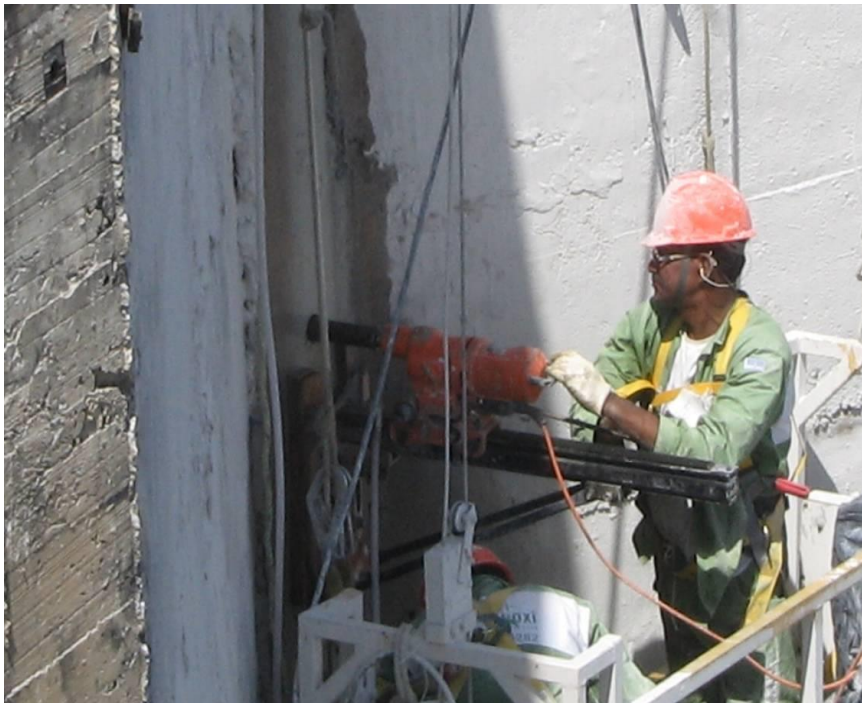
Operação a montante durante o corte das juntas.
