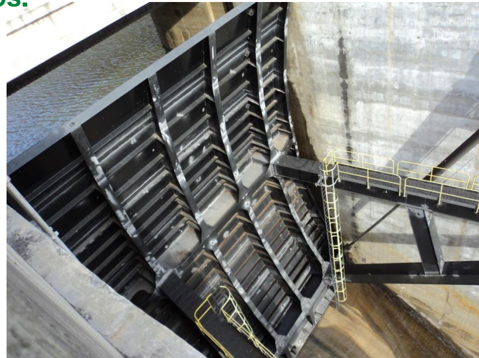
Comporta Segmento da UHE Barra Grande
