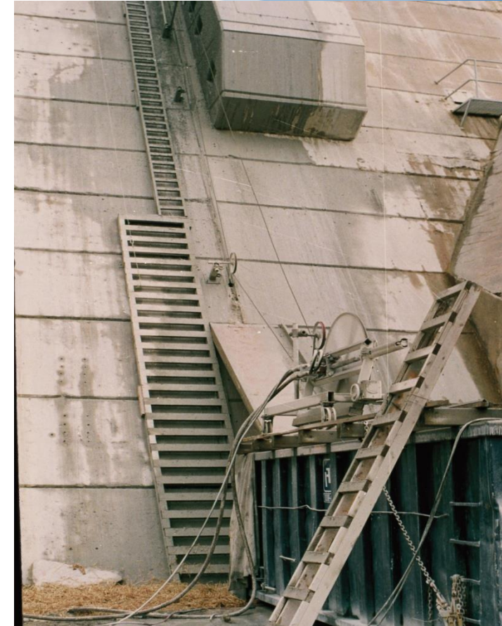
Corte de junta na T.A. com sistema de cabos diamantados.
