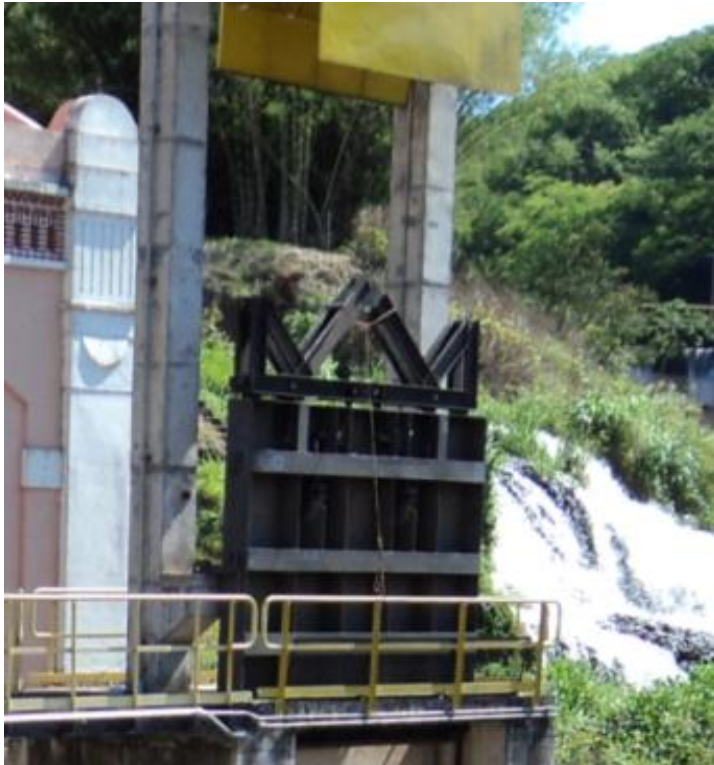
Stoplog sendo içado pela viga pescadora.
