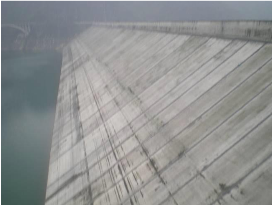
Face de concreto após reparo
