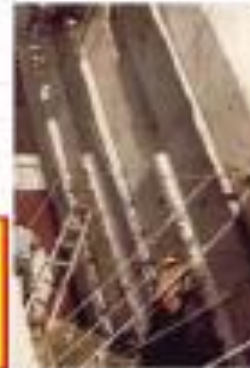
Juntas de contração em barragens e veda-juntas iniciando na fundação (Al Wehdah - Jordânia - 2006) e 3 juntas na barragem de gravidade alviada de Itaipu (1980) (por Andriolo)
