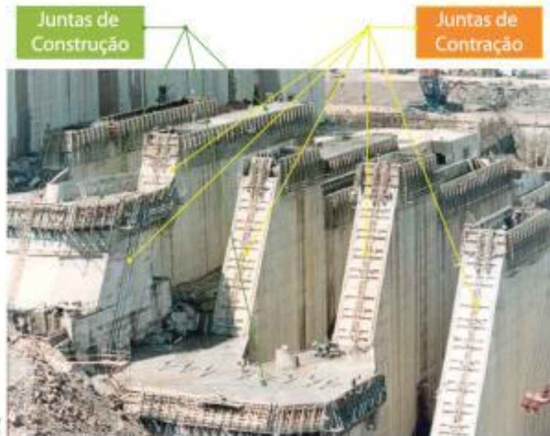
Exemplos de juntas de contração e construção na barragem de gravidade aliviada do Projeto Itaipu, 1997
